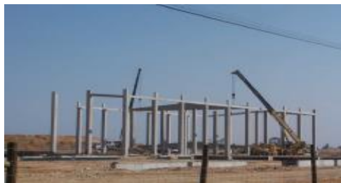
Fig. 29 – Exemplo de edifício industrial com estrutura prefabricada em betão [5]
