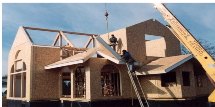
Fig. 11 – Construção com base em SIPS
