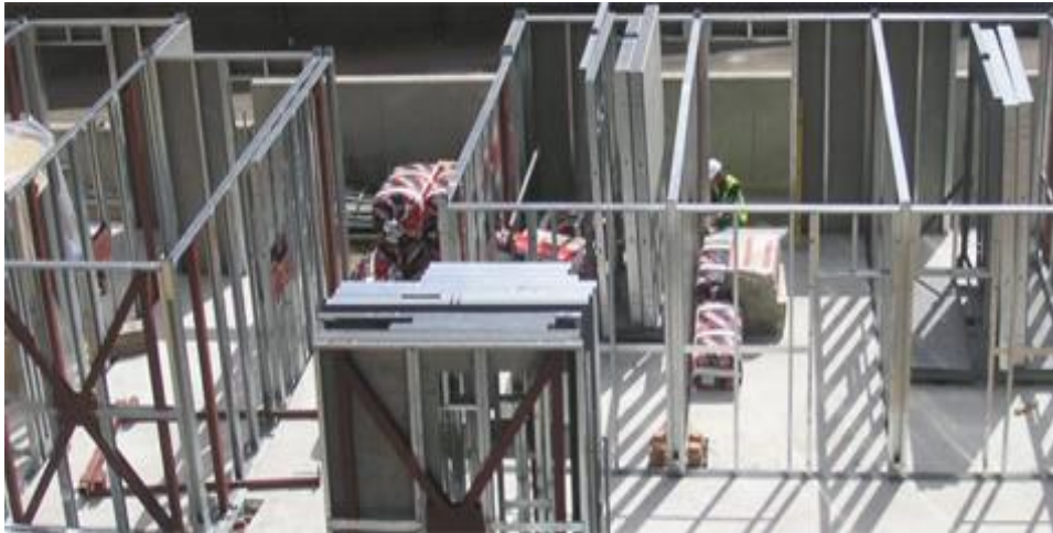
Fig. 8 – Open panels com estrutura em aço
