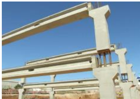
Fig. 28 – Exemplo de componentes estruturais prefabricados em betão [5]
