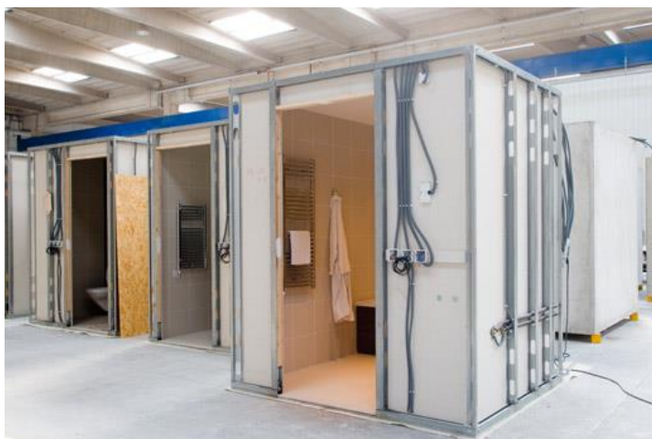
Fig. 12 – Pods de instalações sanitárias
