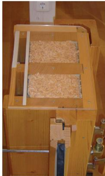
Fig. 17 – Baufritz: utilização de aparas da madeira para isolamento
